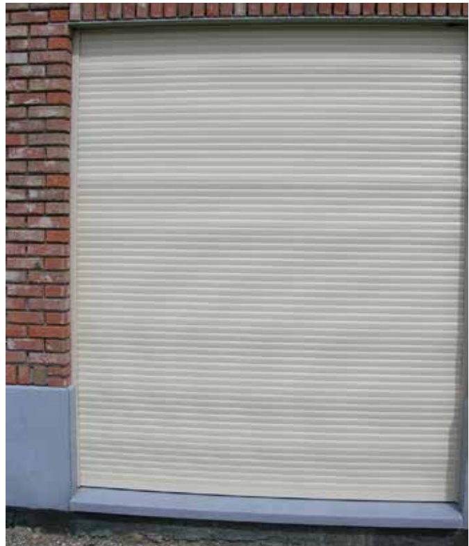
Bild 4: Welligkeit von Rollladenpanzern
